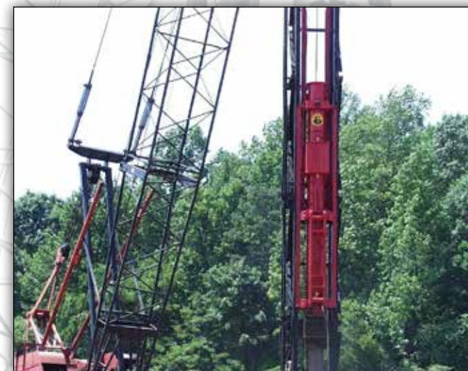
A D19-42 CRAVA VIGA H EM NA CAROLINA DO NORTE.
