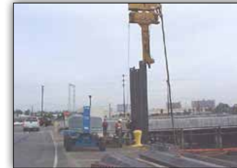
EXTENSÃO HÍBRIDA CHAMADA DE FERRÃO DA CALIFÓRNIA PARA DIMENSÕES DE TRABALHO APERTADAS.
