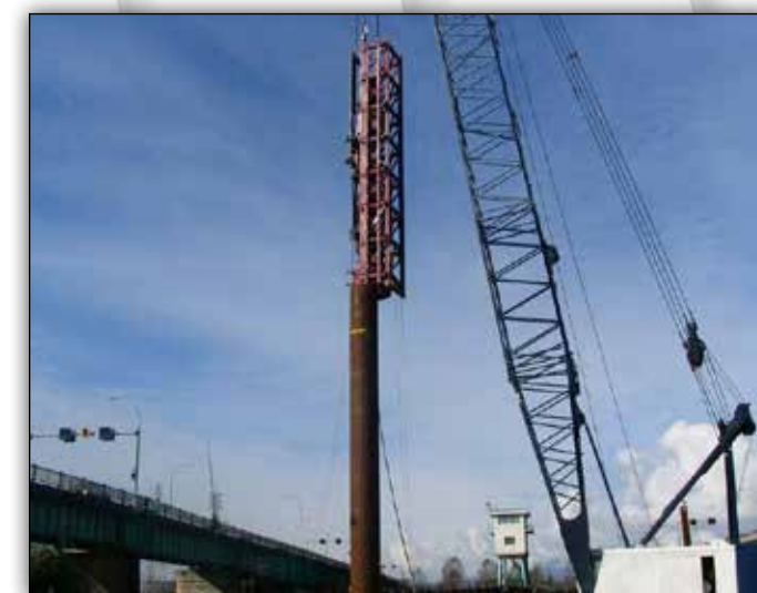
O D180-42, O MAIOR MARTELO A DIESEL DA APE NA AMÉRICA DO NORTE CRAVA UMA ESTACA DE TUBO DE 42" EM COQUITLAM, BC.
