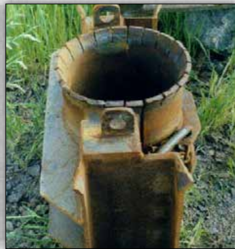
PORTA DA ESTACA FIXADA EM CHUMBO NA CAIXA.
