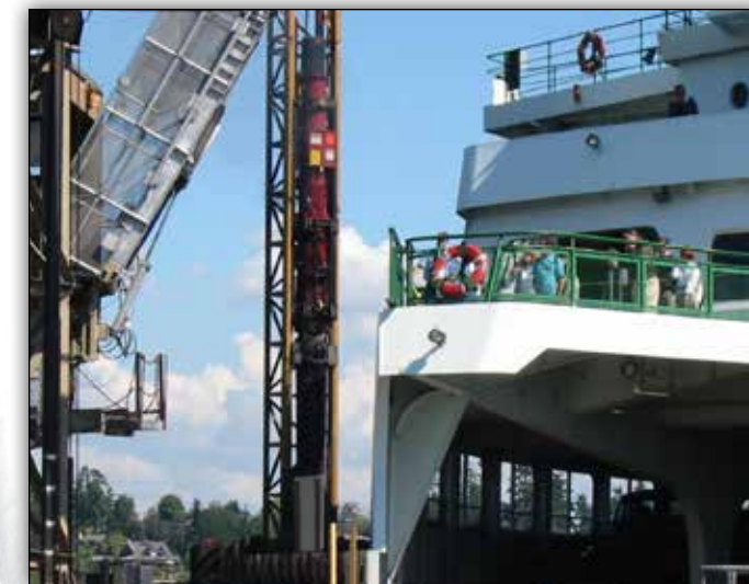
D46 CRAVANDO ESTACAS DE ATRACAÇÃO NO TERMINAL DA BALSA DE BAINBRIDGE ISLAND.
