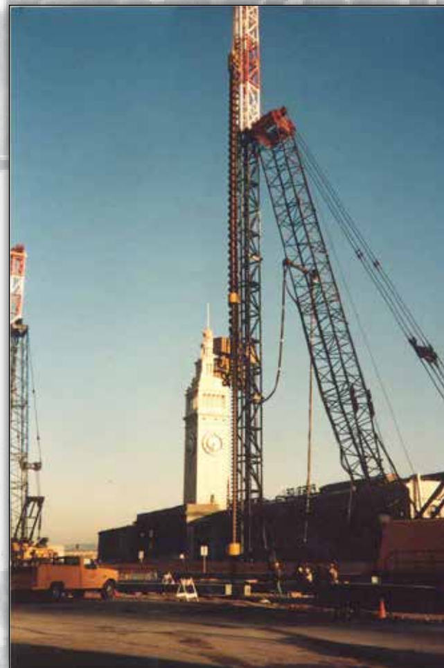
UMA BROCA APE 75 EM FORMATO PRÉ-PERFURAÇÃO AO LADO DE UMA FLECHA FIXA COM UM KING KONG EM SAN FRANCISCO, CA, DE PROPRIEDADE DA KIEWIT.
