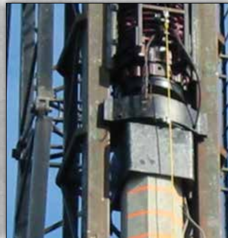
DB32 COM INSERTO DE CAIXA QUADRADO DE 24".
