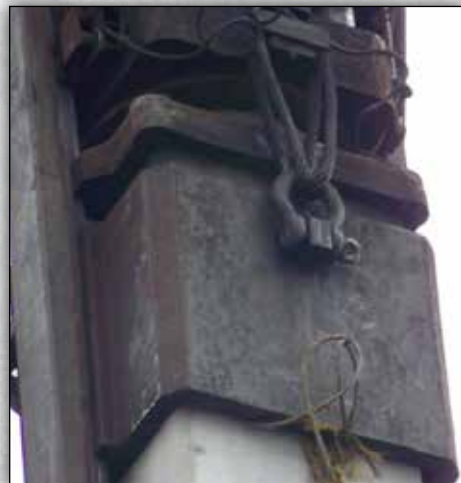
CAPACETE DE CAIXA EM DUAS PEÇAS PATENTEADO.
