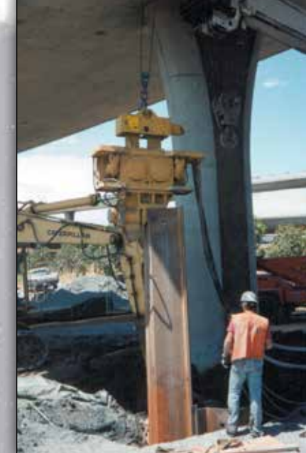
APE 150 EQUIPADO COM SUPRESSOR DE BAIXA ALTURA LIVRE PARA TRABALHO DE ATUALIZAÇÃO NA CALIFÓRNIA.
