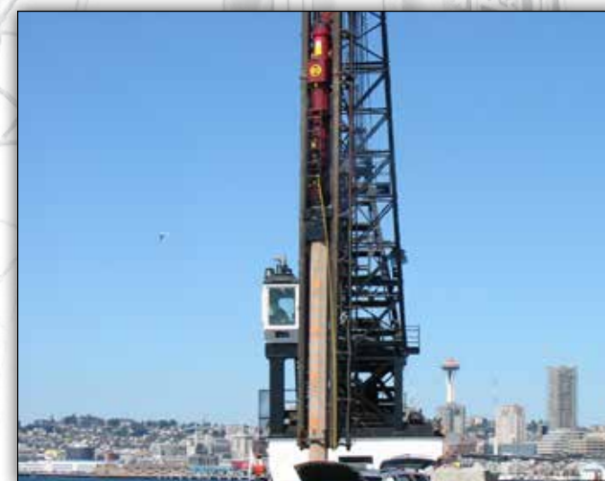
Um D62 CRAVA ESTACAS DE TESTE NO TERMINAL 18 EM SEATTLE, WA.
