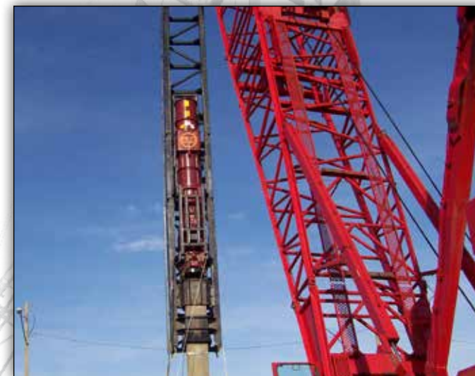
Um APE D160 CRAVA ESTACAS DE CONCRETO QUADRADAS DE 30" EM OCEAN CITY, NJ.
