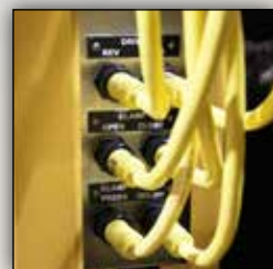
FIAÇÃO DE QUALIDADE DE AVIAÇÃO COM DESCONECTORES RÁPIDOS VEDADOS
