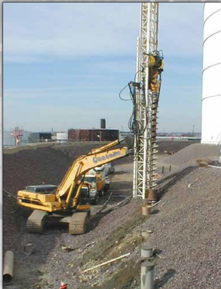
BROCA MODELO 20 MONTADA NA FLECHA DE CREMALHEIRA E PINHÃO APE COM 15.000 LIBRAS DE CAPACIDADE DA EQUIPE.
