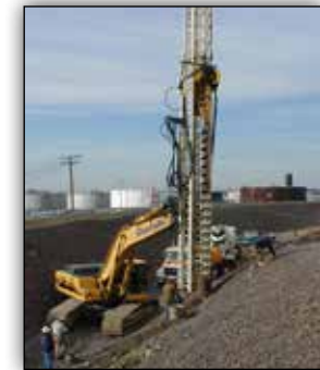
MONTAGEM NA ESCAVADEIRA
