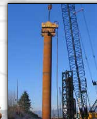
MODELO 600 VIBRO COM O D180-42. ACABAMENTO EM ESTACAS DE 1,8 M.
